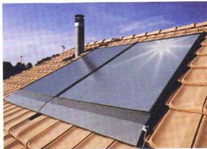
Esempio con strutture d'appoggio visibili, inoltre la collocazione irrispettosa della forma del tetto (fino a coprire il colmo) e la scarsa cura nella sistemazione degli elementi di supporto, producono effetti negativi sul paesaggio.
